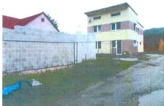
Rozostavaná stavba na pozemku 1392/16
