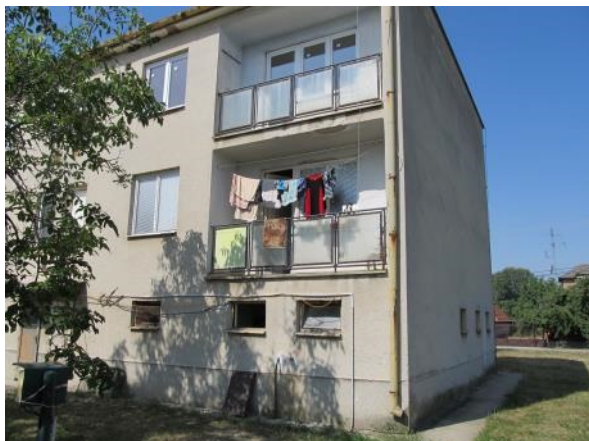
Fotka č. 19 - zsadný pohľad na dom
