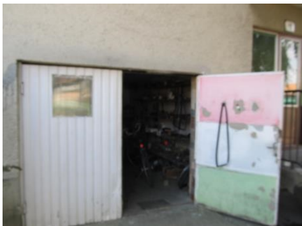
Fotka č. 17- vstup do garáže
